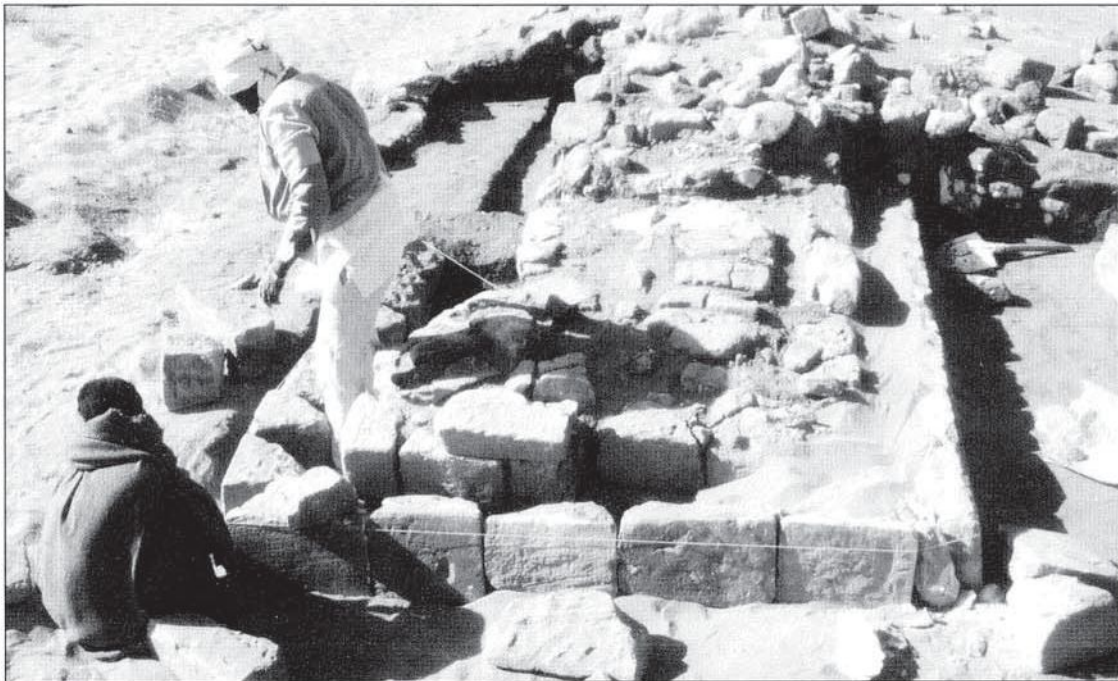
Abb. 4: Schutzmaßnahmen zur Erhaltung der Reste des Haupttores: Ummauerung mit Sandsteinblöcken, Einbettung in reinem Sand (Dia Nr. 2000 - 42/5).
