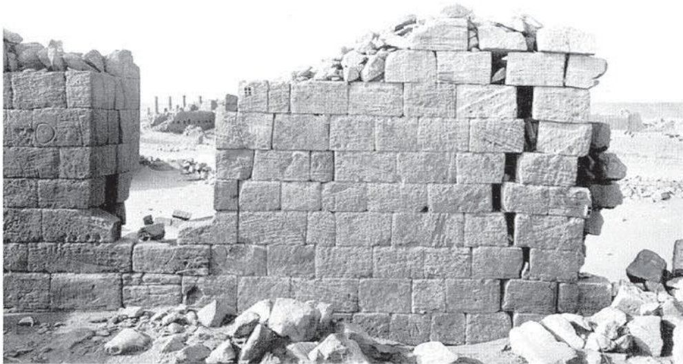
Musawwarat, Große Anlage: Meßbild einer gefährdeten Mauer.
