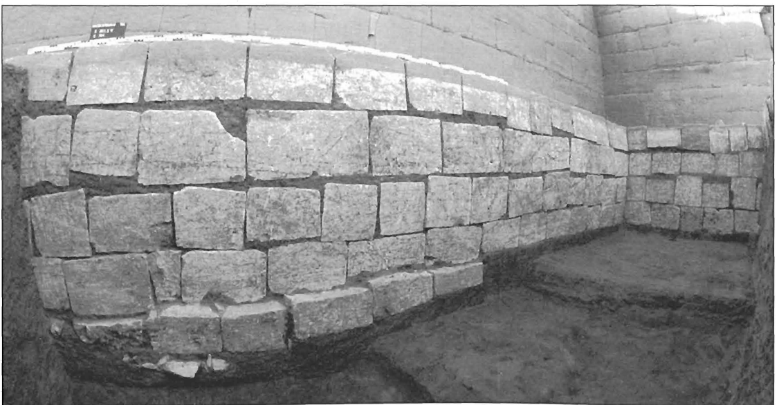
Abb. 5: Tempel 300, Fundamentausprägung in der Grube unterhalb der Mitte des Tempels 300 (Neg.Nr. 1295/5).
