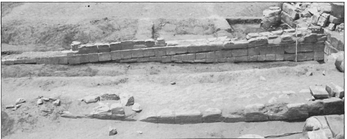
Abb. 3: Tempel 300, Rampe 303, westliche Rampenmauer von Ost (Foto: P. Wolf).
