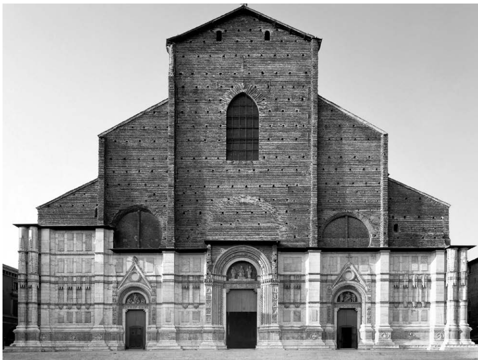
4 Bologna, San Petronio, facciata
