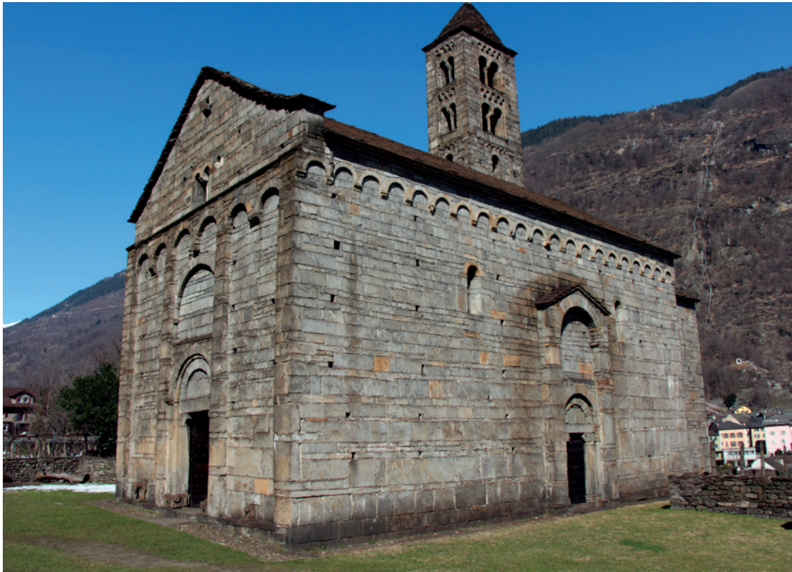
4 Giornico, San Nicolao, Ansicht von Südwesten
