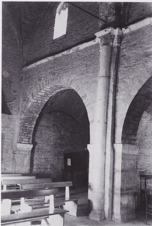
20 Presbyterium nach Nordwesten; im Hintergrund die Lettnerwand mit dem eingemauerten Arkadenpfeiler auf der Kryptenwestwand.
