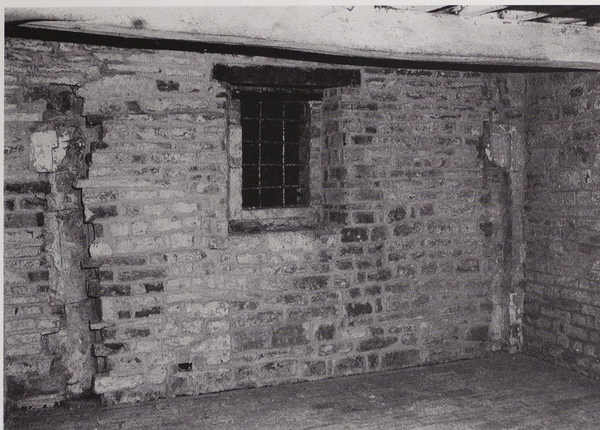
31 Westbau, nördliches Joch nach Osten gegen die Vermauerung der Seitenschiffarkade; rechts die eingemauerte Pfeilervorlage, links die Wandvorlage.
