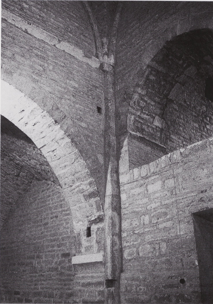
41 Presbyterium, Mittelschiff nach Südwesten, Anschluß des südlichen Arkadenpfeilers zum Lettner; erst oberhalb des Kämpfergesimses durchgehender Mauerverband.
