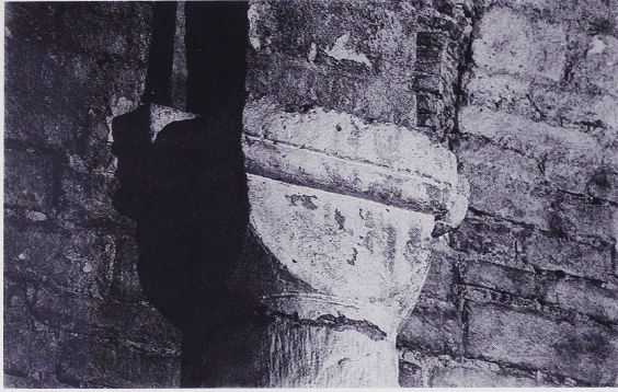
44 Laienkirche, Wandvorlage im südlichen Seitenschiff, Würfelkapitell mit Gewölbeansatz.
