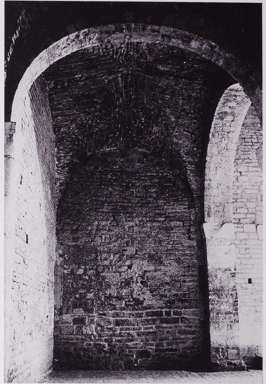
34 Laienkirche, südliches Seitenschiff nach Westen gegen die Vermauerung der Seitenschiffsarkade; rechts der südliche Westpfeiler mit Vorlage und Gurtbogen, links ein Stück der Wandvorlage.
