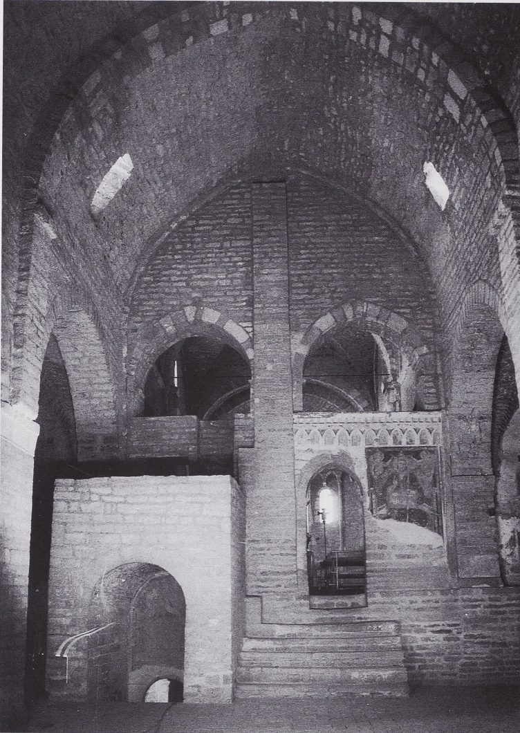
15 Laienkirche, Mittelschiff nach Osten gegen die Lettnerwand, Aufnahme 1922 (vor der Restaurierung 1922-30); rechts und links die zugemauerten Arkaden.
