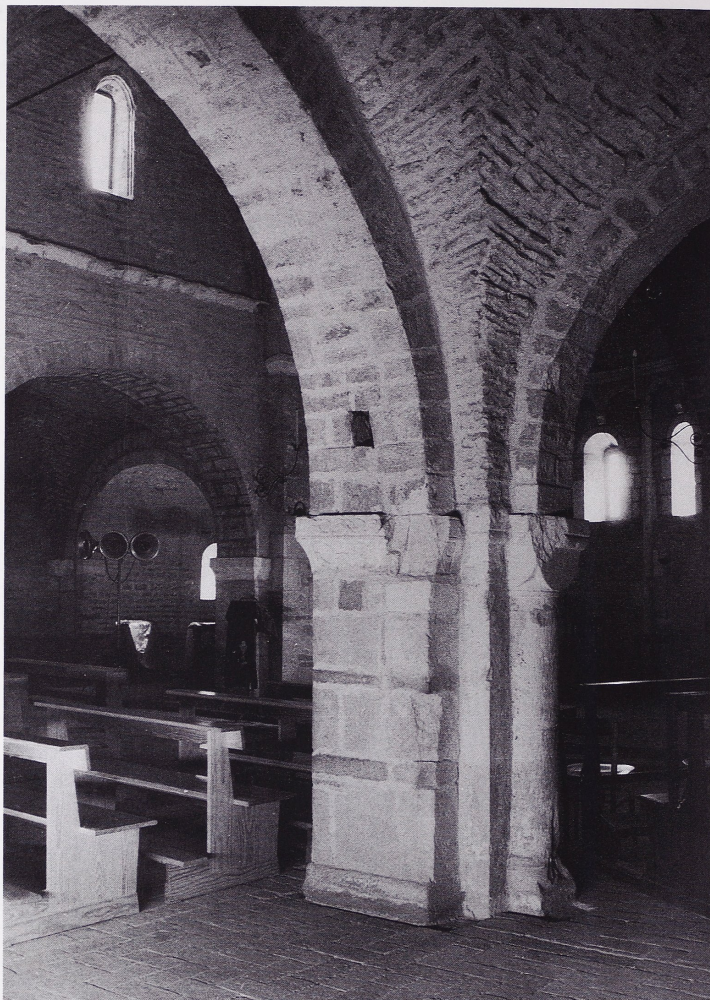
45 Presbyterium, südlicher Arkadenpfeiler von Südwesten; Vorlage zum Seitenschiff mit Ansatz der Gewölbe.
