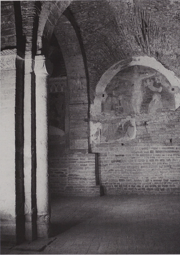
17 Laienkirche, südliches Seitenschiff nach Osten gegen die Lettnerwand mit der Darstellung der Kreuzigung; links daneben der eingemauerte Arkadenpfeiler auf der Kryptenwestwand; im Vordergrund Pfeilervorlage des südlichen Mittelschiffpfeilers.
