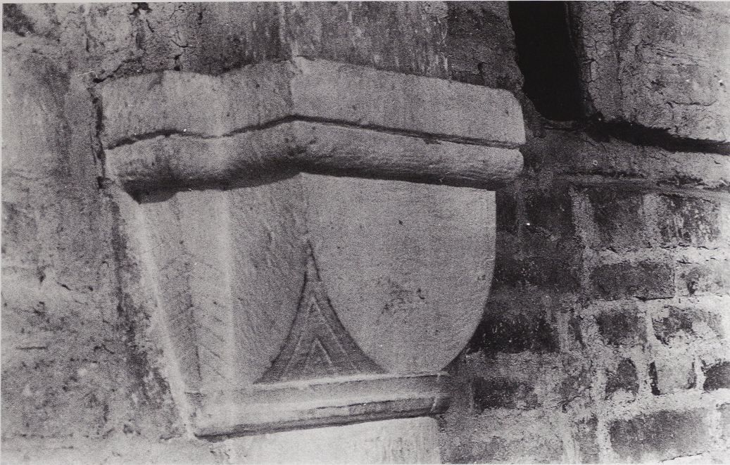
46 Presbyterium, Wandvorlage im südlichen Seitenschiff, Würfelkapitell mit Gewölbeansatz.
