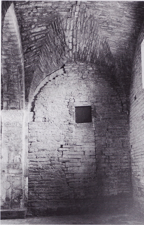
33 Laienkirche, nördliches Seitenschiff nach Westen gegen die Vermauerung der Seitenschiffsarkade; links der nördliche Westpfeiler mit Vorlage und Gurtbogen.
