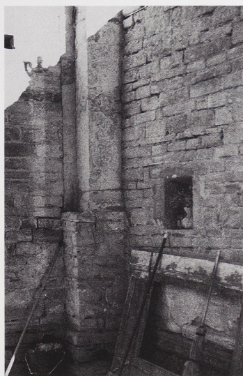
39 Laienkirche nach Osten, Lettnerwand mit eingemauertem Pfeiler der südlichen Langhausarkade; Kämpferkapitell mit der Darstellung von Raubtieren.
