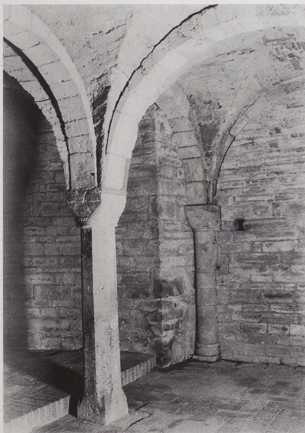
27 Mittelkrypta nach Südosten, Pfeilertyp 3: 'Variante' des Achteckpfeilers; im Hintergrund Wandvorlage.
