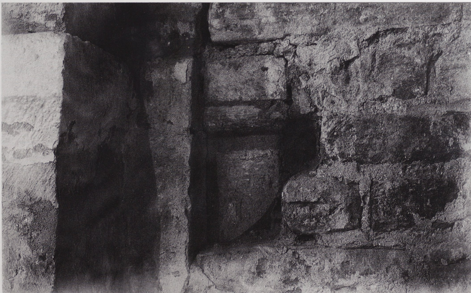
47 Presbyterium, in der Lettnerwand eingemauerter nördlicher Arkadenpfeiler, Vorlage zum Seitenschiff, Würfelkapitell.
