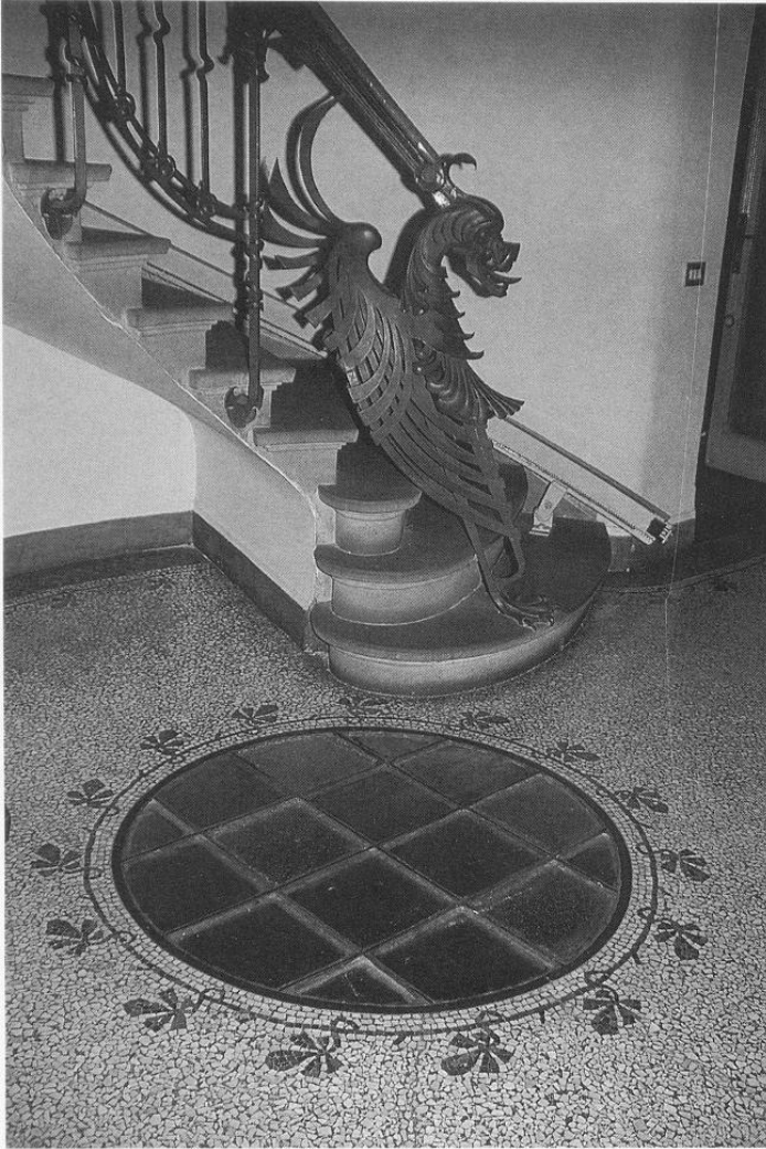
31 Villino Broggi-Caraceni, Treppenhaus mit verglastem Fußbodenausschnitt.
