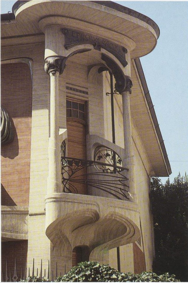
26 Villino Broggi-Caraceni, Eckbalkon.
