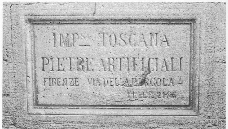
3 Casa-Emporio, Fassadendetail der unteren Sockelzone.
