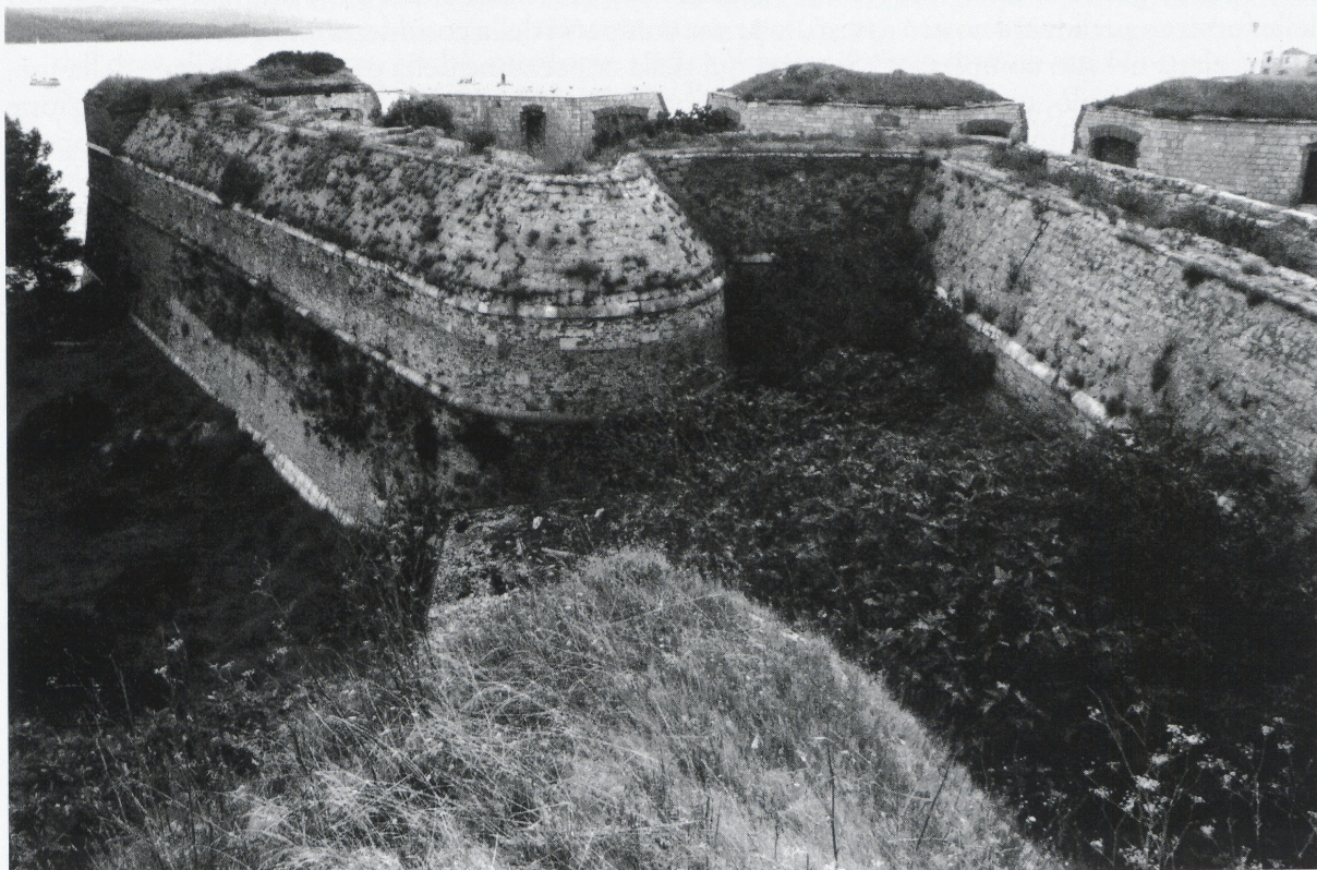
15 San Nicolò, vista sul semibastione occidentale.
