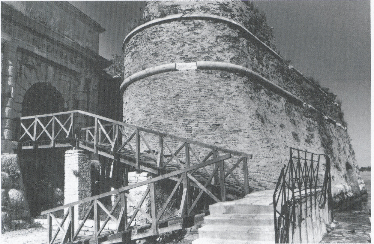
4 San Nicolò, portale e lato orientale del baluardo circolare.
