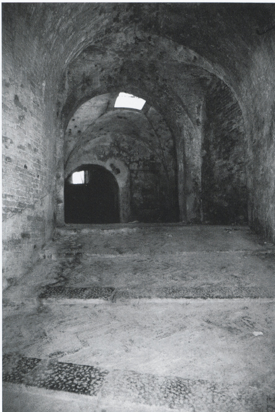
7 San Nicolò, rampa, vista dal livello inferiore verso sudest.
