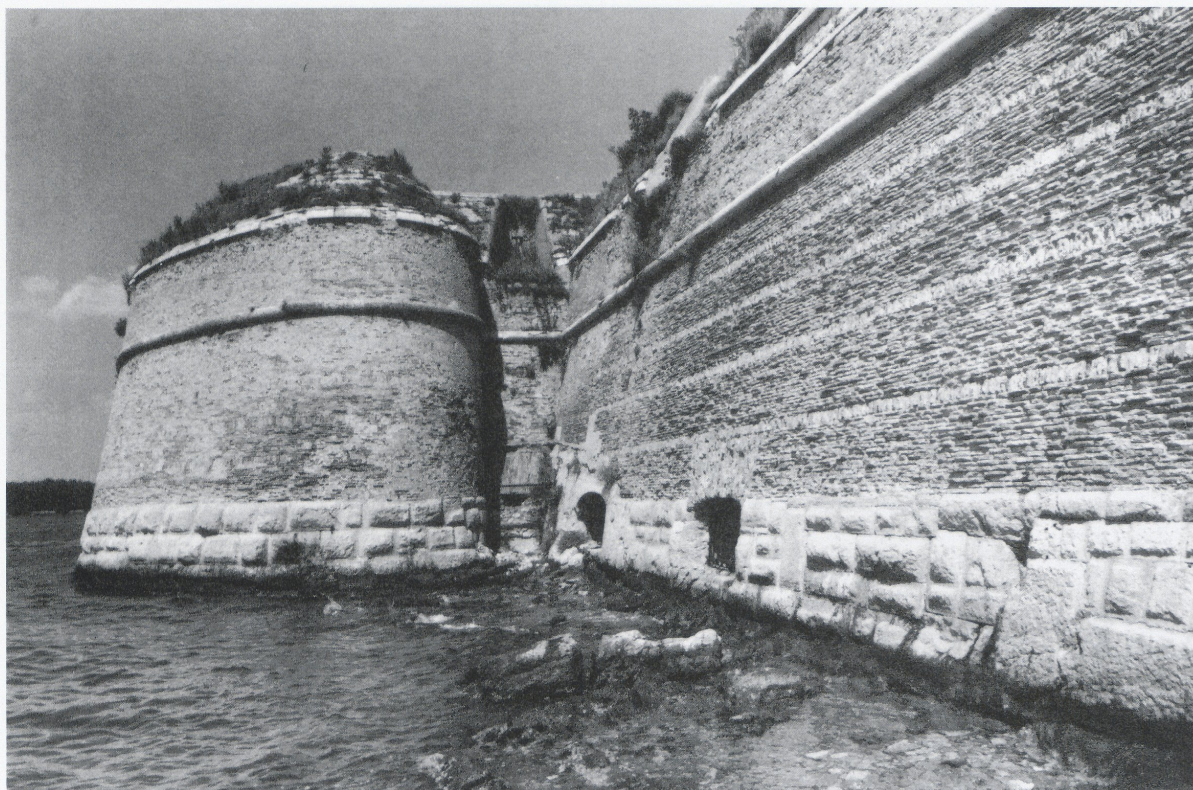
12 San Nicolò, orecchione e fianco ritirato occidentale del baluardo circolare e cortina occidentale.
