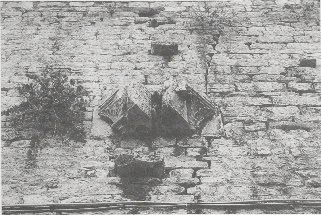
4 Prato, Kastell, winkelförmiger Quader mit zwei Gewölbekonsolen, Quaderzapfen und Schildbogenlinien (NW 4).
