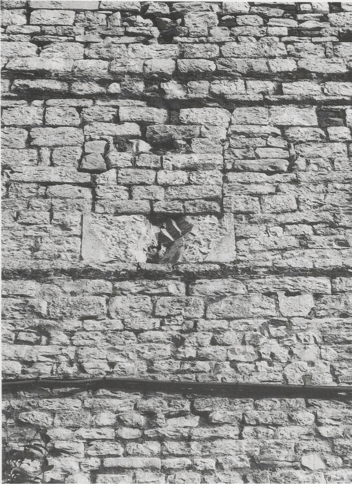
7b Winkelförmiger Quader (SE 2). Prato, Kastell, abgearbeitete Konsolen an der Südostkurtine.
