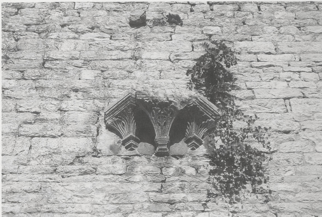
3 Prato, Kastell, monolithischer Quader mit äußeren Gewölbekonsolen und mittig sitzender Gurtkonsole (NW 3).
