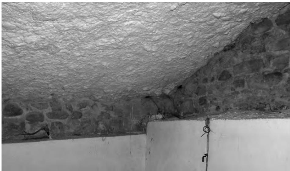
8 Muratura di fondazione e dettaglio di volta nel piano interrato della casa in via della Colonna 17. Per gentile concessione della famiglia Marzi
