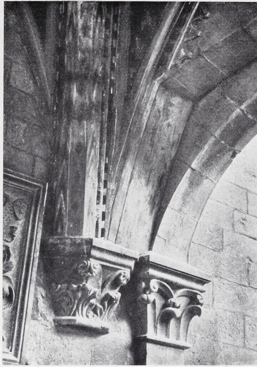
Abb. 16. Palazzo del Podestà, drei Bauschichten über der oberen Mündung der Freitreppe; vgl. S. 311 1
