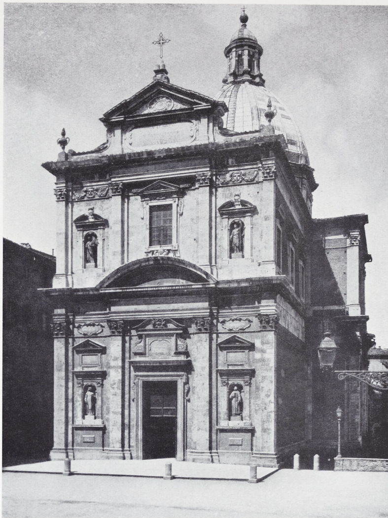
Abb. 2. Siena. Chiesa di Provenzano. Fassade (Fra D. Schifardini)
