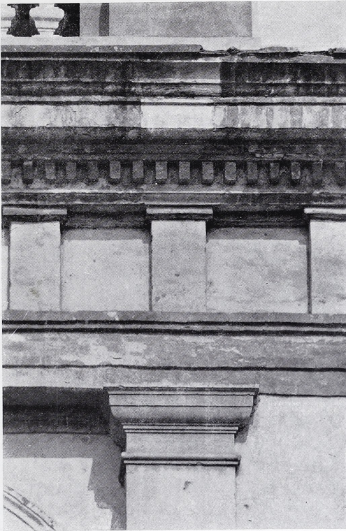
11 J. Sansovino, Villa Garzoni, Detail des dorischen Gebälks an der Fassade.
