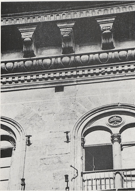
8 Palazzo Medici-Riccardi, Baunaht in der Fassade an der Via Cavour.
