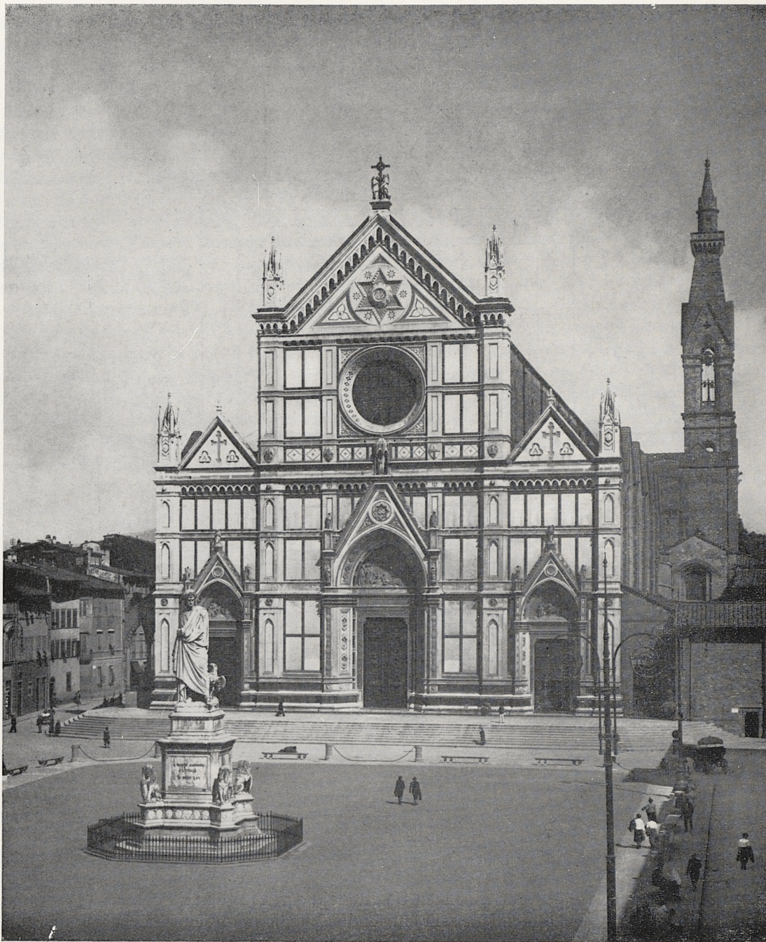
10 Nicola Matas, Fassade von S. Croce,
