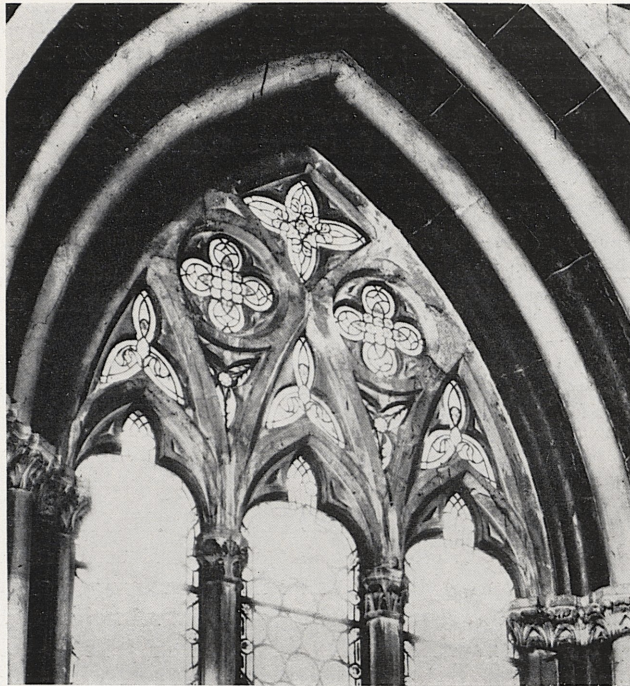
22 Siena, Dom, Masswerk eines Obergadenfensters.
