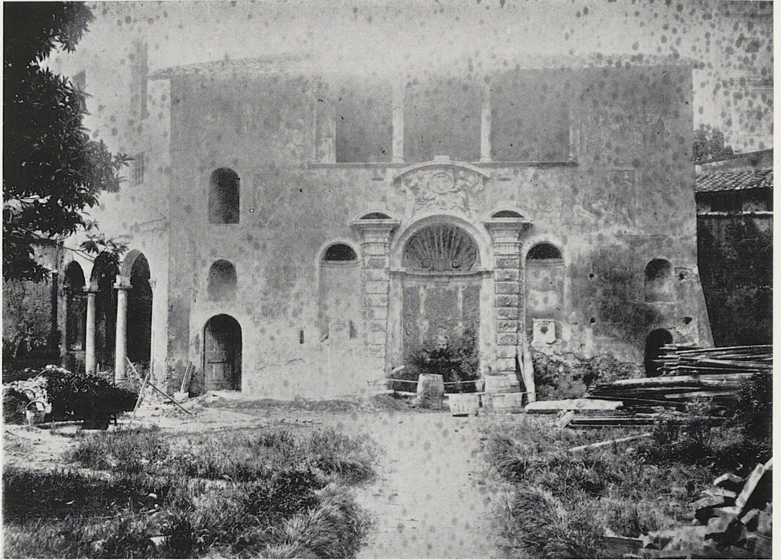
3 Gartenhaus Bufalo, Frontansicht (kurz vor dem Abbruch). – Foto im Museo di Roma.
