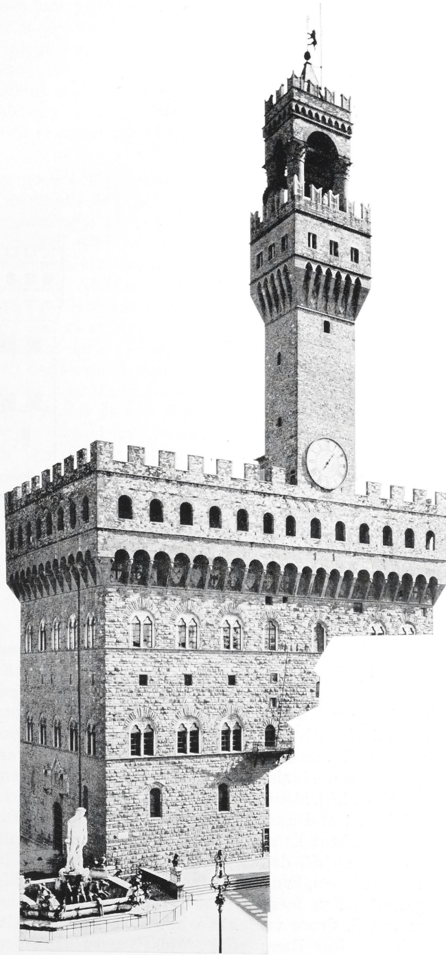
8 Florenz, Palazzo Vecchio, ursprünglicher Hauptbau.
