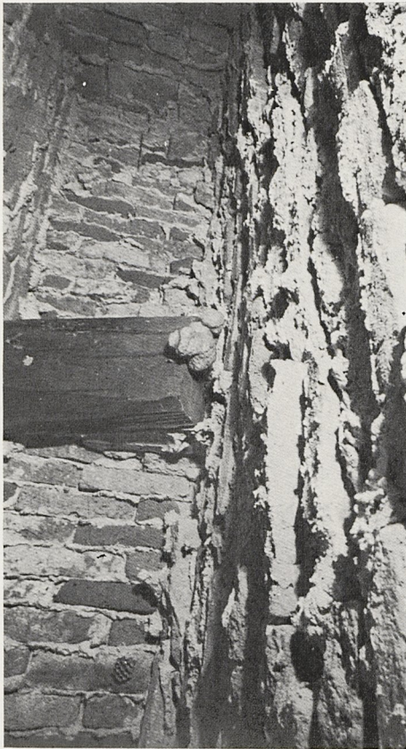
34 e 35 Soltanieh, cupola del mausoleo. Nello spazio fra le due cupole si vedono i legni delle armature dei ponti rimasti imprigionati.
