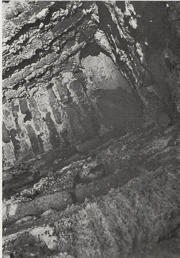
34 e 35 Soltanieh, cupola del mausoleo. Nello spazio fra le due cupole si vedono i legni delle armature dei ponti rimasti imprigionati.
