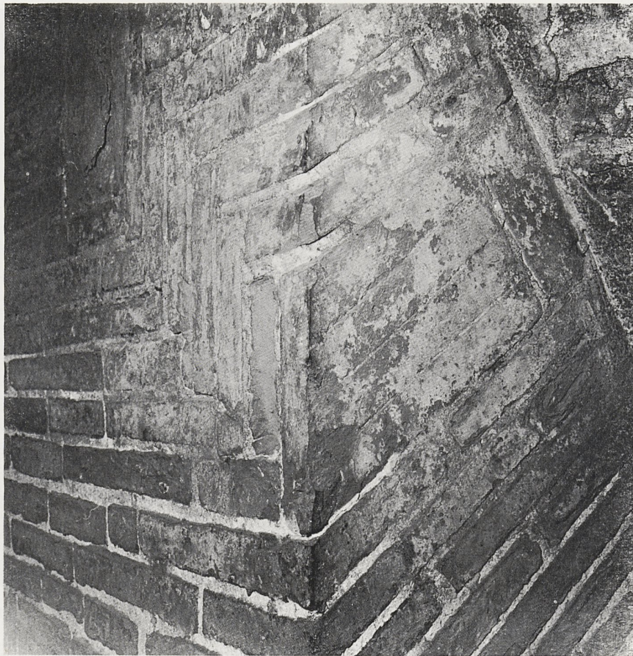
36 Firenze, cupola di S. Maria del Fiore. Particolare dell'apparecchio dei mattoni (cf. disegno, fig. 37).
