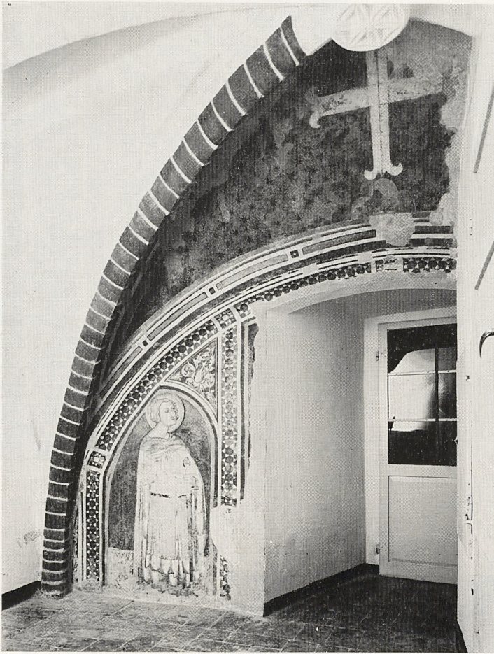
19 Ehemaliger Turm von S. Agostino in Siena, Raum « E »).
