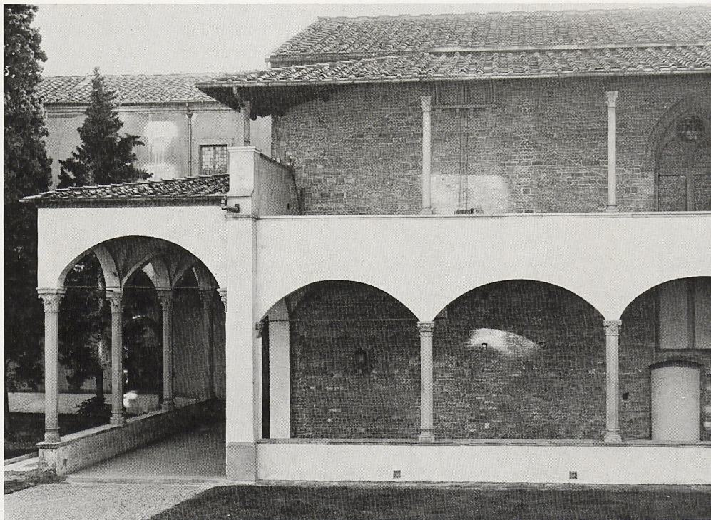
7 Teilansicht des dem "arnolfinschen" Refektorium im Norden vorgelagerten zweigeschossigen Arkadengangs. (Unterhalb des Obergeschossdaches erkennt man an der Refektoriumsmauer den ursprünglichen Dachansatz des Zwischentraktes.)
