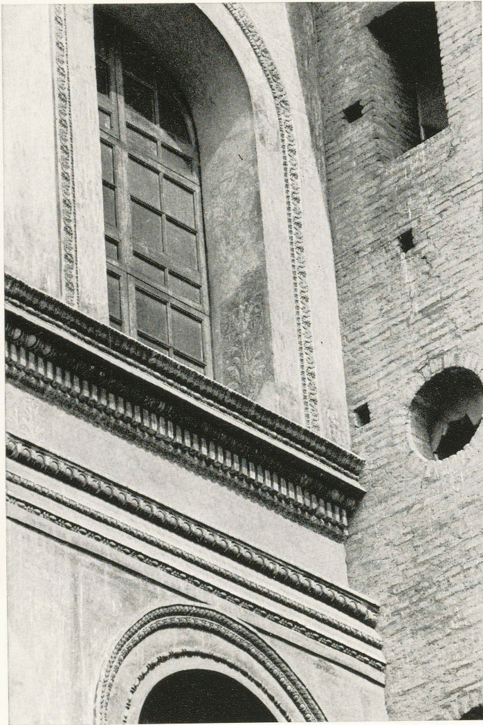
2 Mantua, S. Andrea, Seitenfront des Portikus. Fenster in der obersten Zone oberhalb der Nische (Abb. 6).
