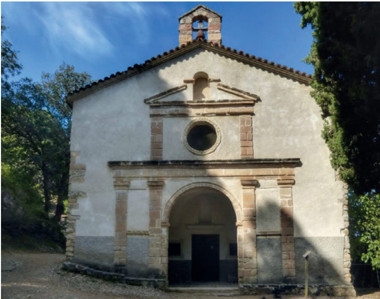
4 Ulldemolins, eremo di Santa Magdalena de Montsant, facciata
