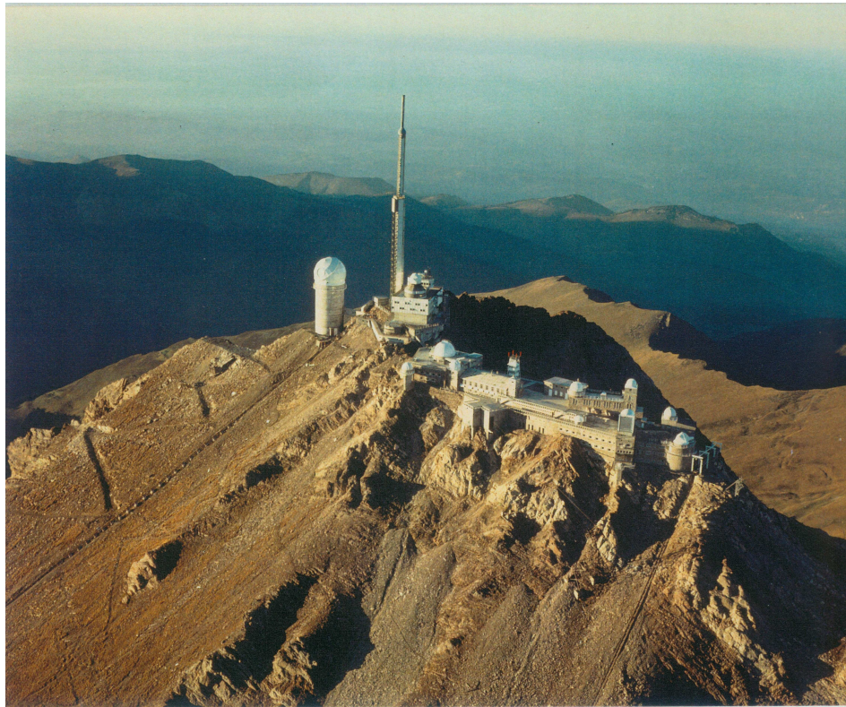
Abbildung 9.9: Observatoire Pic du Midi (1878), 1903, Pic du Midi, neuere Gesamtaufnahme in Richtung Nord (Photo: Peter Müller)
