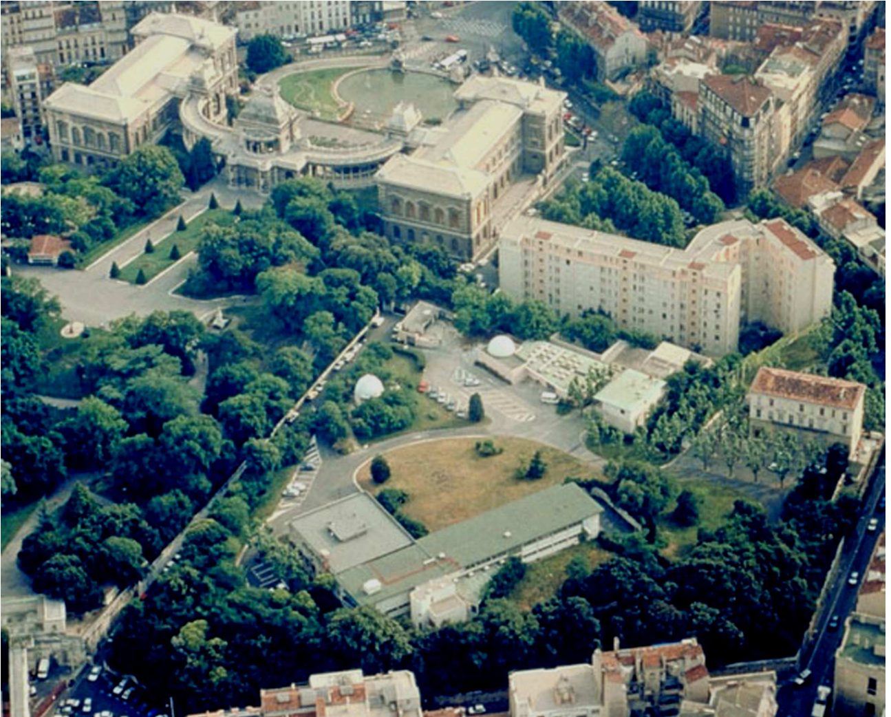
Figure 14.1: Aerial view of Marseille Observatory (Marc Heller, 1997, ©Région Provence-Alpes-Côte d'Azur – Inventaire général)
