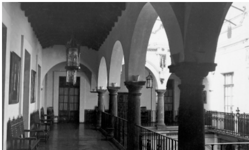
El patio visto desde la planta alta.
