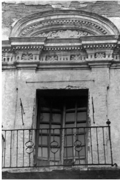
Av. 5 Poniente 133 (n° cat. 693) Detalle del frontón circular.
