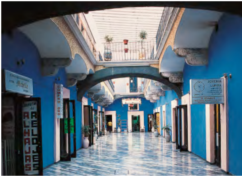
II. 10: El mismo edificio (n° cat. 340) restaurado se presenta en 2001 como pequeño centro comercial.
