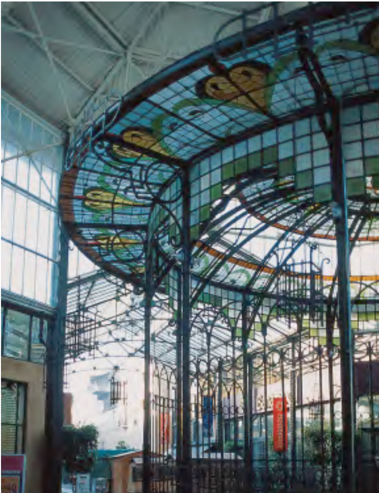
II. 3: El kiosk en el Mercado de la Victoria se construyó de acero y de vidrio de color que marca el centro del edifi-
