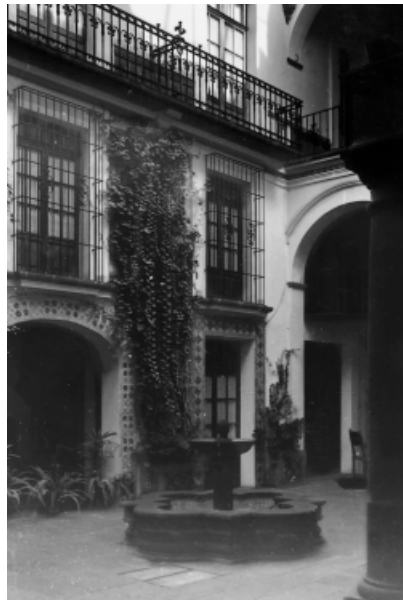
· El lado oeste del patio.
