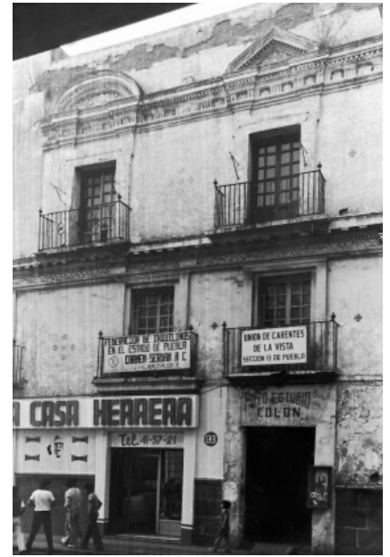
Av. 5 Poniente 133 (n° cat. 693) La fachada completa con su entresuelo y con los singulares marcos de ventana del siglo XVII en la planta alta. Están comunicados entre sí por un friso.
