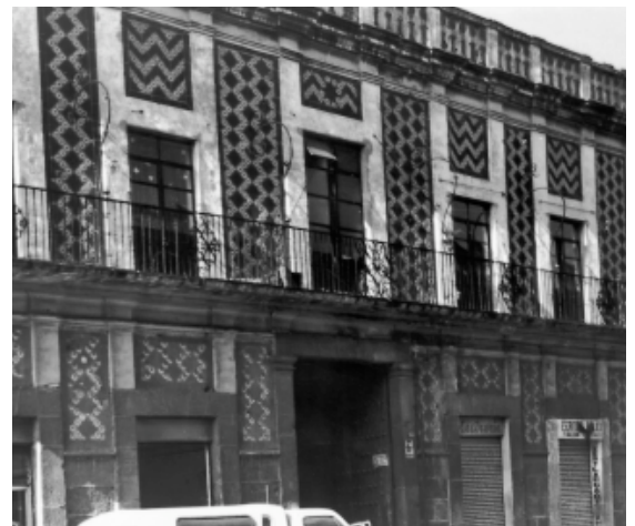
° Av. 2 Oriente 413 (n° cat. 162) La «casa de los Toledo» con fachada clásica del siglo XVIII en Puebla.
