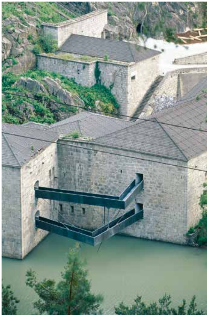
2 Festung Franzensfeste, Verbindungsbrücken am Nordost-Trakt von Architekt Markus Scherer.
