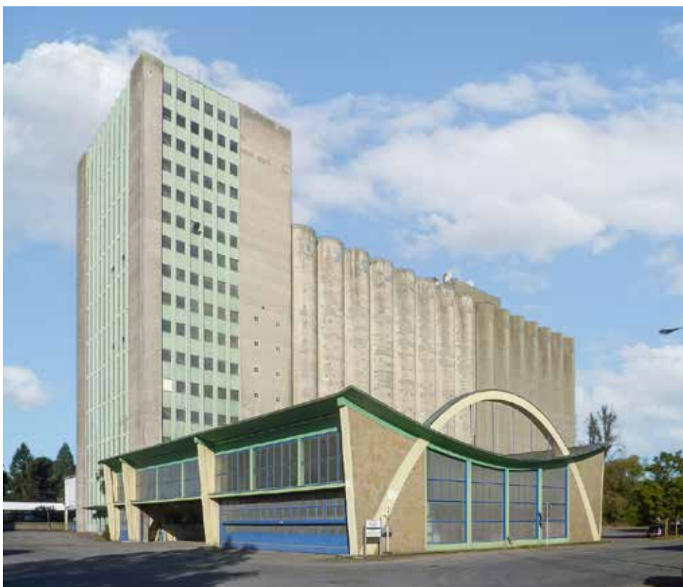
3 Die Siloanlage in Mersch aus dem Jahre 1958 war das Herzstück der nationalen Agrarindustrie. Die in Vorspannbetontechnik erstellte, architektonisch bemerkenswerte Kornhalle war für den gesamten Bauernstand symbolträchtige Anlaufstelle zur Erntezeit. Abriss 2019.
