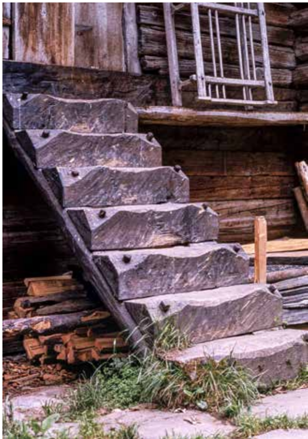
2 Aus lokalem Material etwas Schönes zu schaffen, sollte wieder Herausforderung unserer Zeit werden. Vollholztreppe Ballenberg, Haus Nummer 1011 von Adelboden, Foto 1980.
