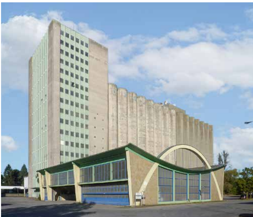
3 Die Siloanlage in Mersch aus dem Jahre 1958 war das Herzstück der nationalen Agrarindustrie. Die in Vorspannbetontechnik erstellte, architektonisch bemerkenswerte Kornhalle war für den gesamten Bauernstand symbolträchtige Anlaufstelle zur Erntezeit. Abriss 2019.
