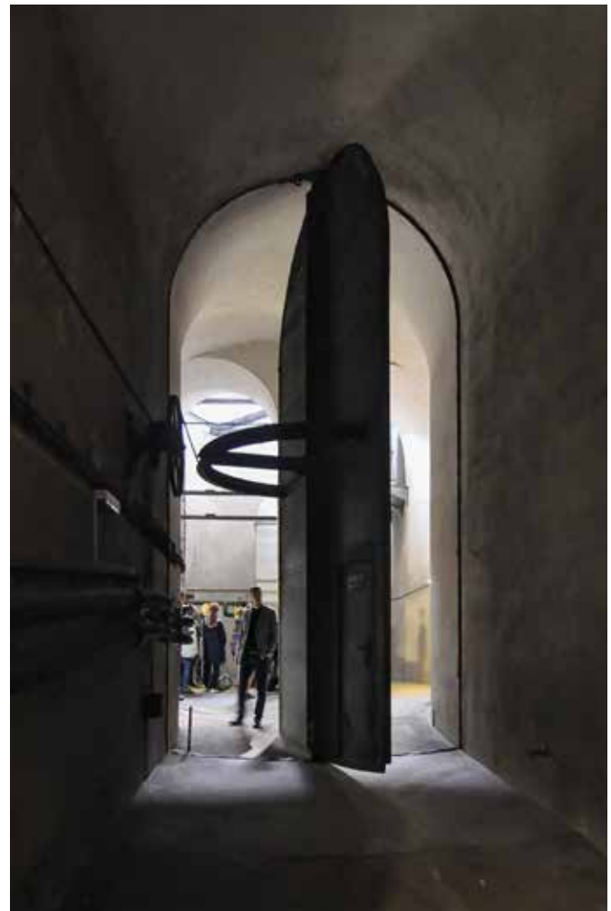
4 Grosses Drehtor am Beginn des Tunnels im Luftbrunnen im Wiener Burgtheater.
