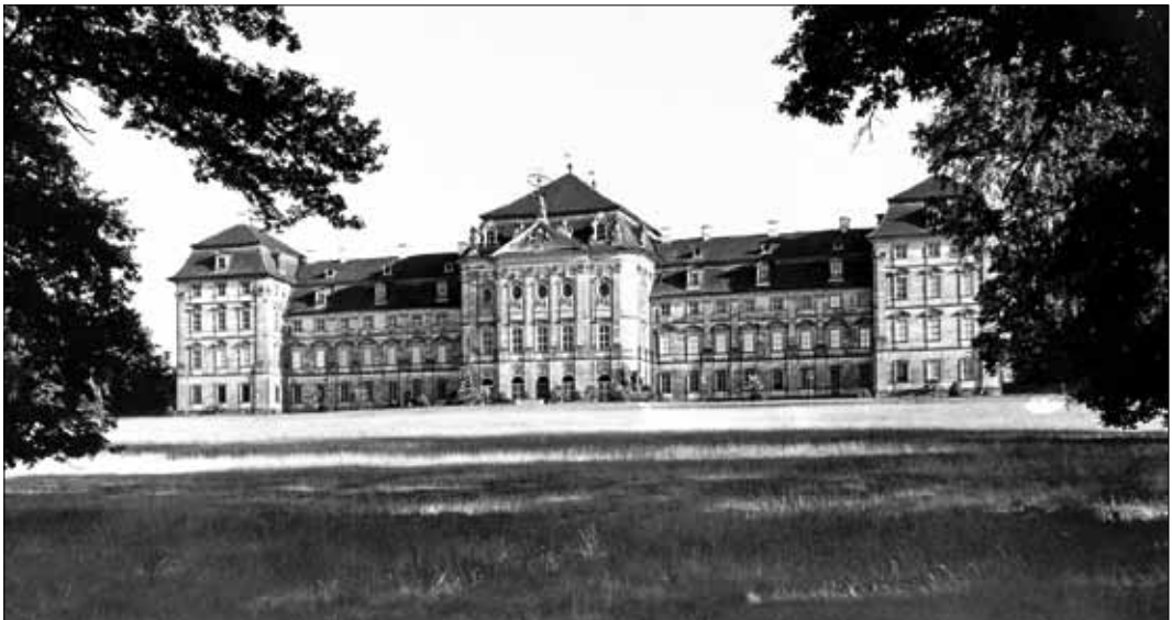
Abb. 5: Pommersfelden, Schloss Weißenstein, Gartenansicht des Schlosses mit der weitgehend steinsichtigen Fassade, die mangels klarer Befunde bei der Restaurierung in den 1970er Jahren beibehalten wurde (Foto: Bayerisches Landesamt für Denkmalpflege)
