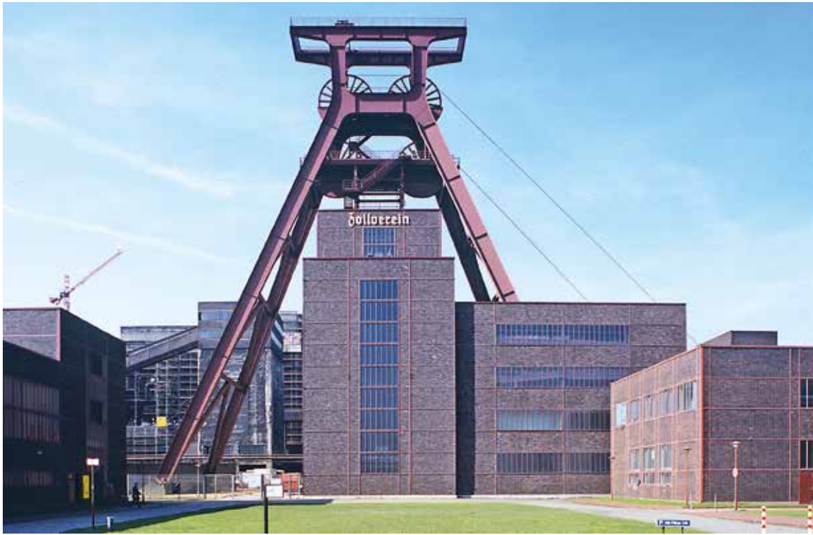
Industriedenkmal Zeche Zollverein in Essen, Doppelbock von Schacht 12, seit 2001 Weltkulturerbe Zollverein Coal Mine Industrial Complex, headframe of shaft 12, World Cultural Heritage since 2001 Patrimoine industriel de la mine «Zeche Zollverein» à Essen, chevalement double du puits 12, inscrit au patrimoine culturel mondial depuis 2001
