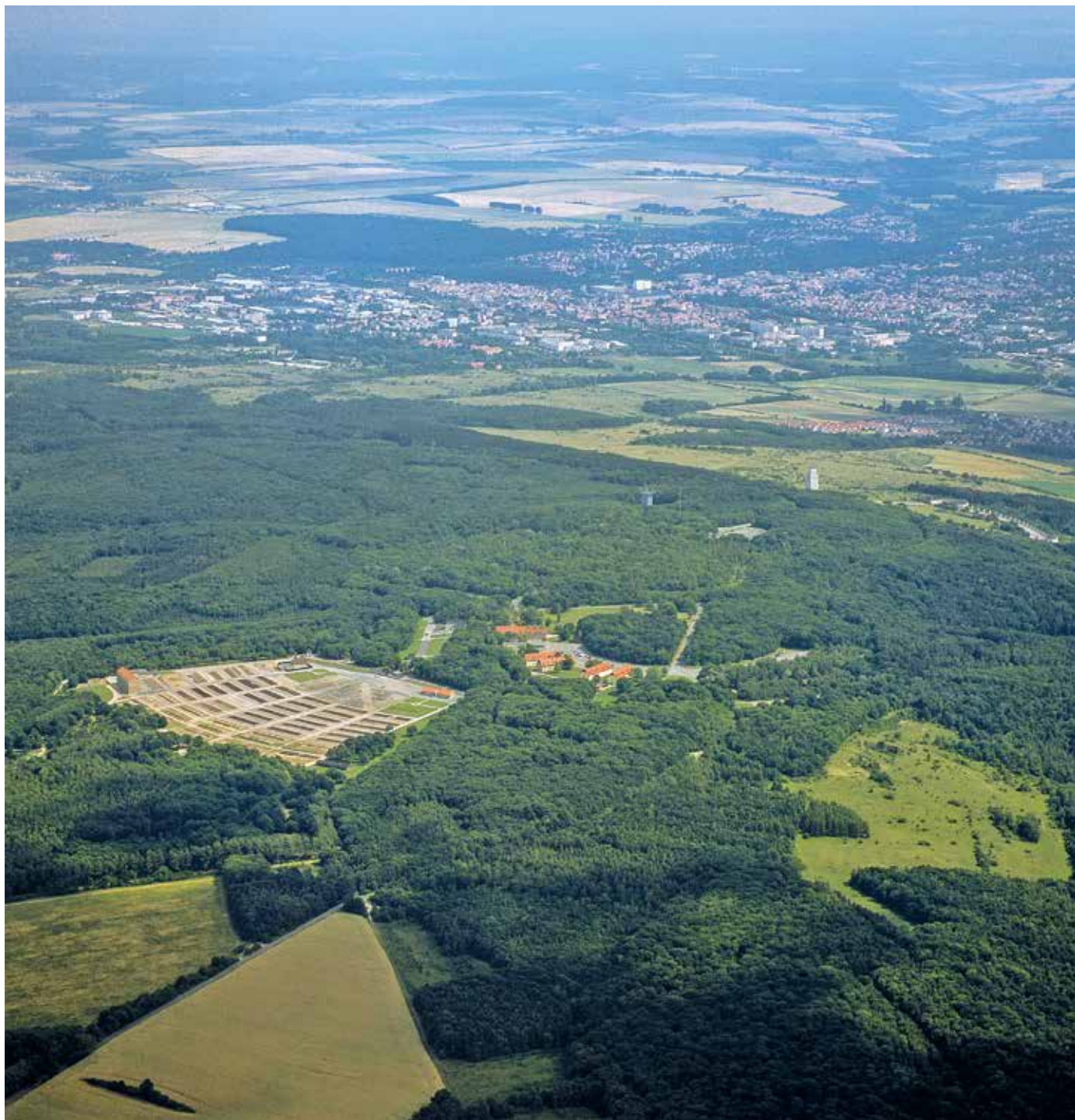
Luftbild des Konzentrationslagers Buchenwald bei Weimar Aerial view of the Buchenwald Concentration Camp near Weimar Vue aérienne du camp de concentration de Buchenwald à proximité de Weimar
