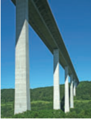
Kochertalbrücke bei Geislingen (Foto: Karl Fisch, LAD).
