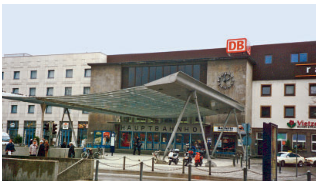
3 Ulm Hbf mit neuem Intercity-Hotel (links) und Glasvordach.
