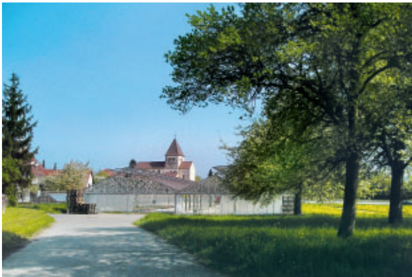
2a+b Reichenau-Oberzell. Erhaltene Grünstäur und Sichtachse zwischen dem Südufer und St. Georg, im Norden durch ein Gewächshaus beeinträchtigt, 2006.
