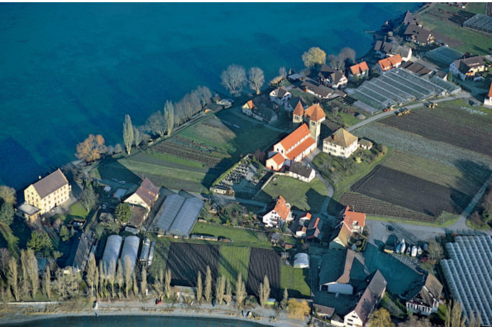
5 Reichenau-Niederzell. Der westliche Teil der Gesamtanlage mit Schloss Windeck, Stifts- kirche St. Peter und Paul sowie Pfarrhaus, 1999.
