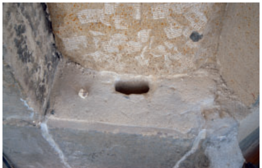
5 Ausarbeitung auf der Fugenfläche für einen Spreizwolf, 2009.
