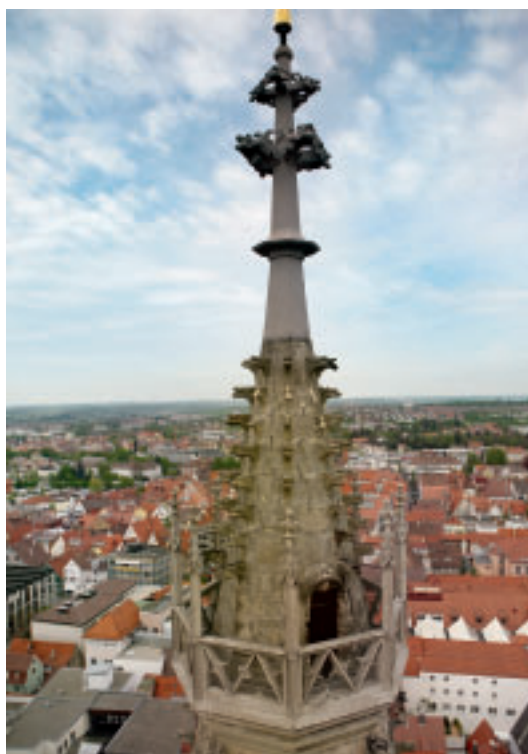
1 Spitze des Turmhelms, Foto des Vorzustands 2007.
