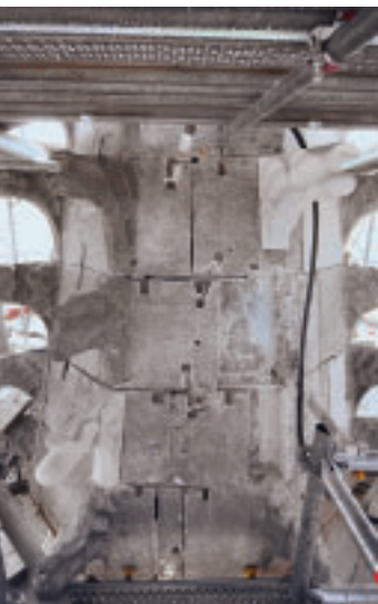
3 Turmdetail mit aktuellen Maßnahmen, 2009.
