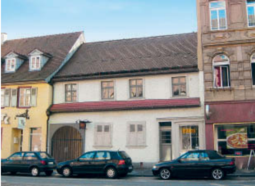
3 Das „Seilerhäuschen“, Kaiserstraße 47, ein Bau des Jahres 1723, der in seinem Gesamtgefüge erhalten werden konnte.
