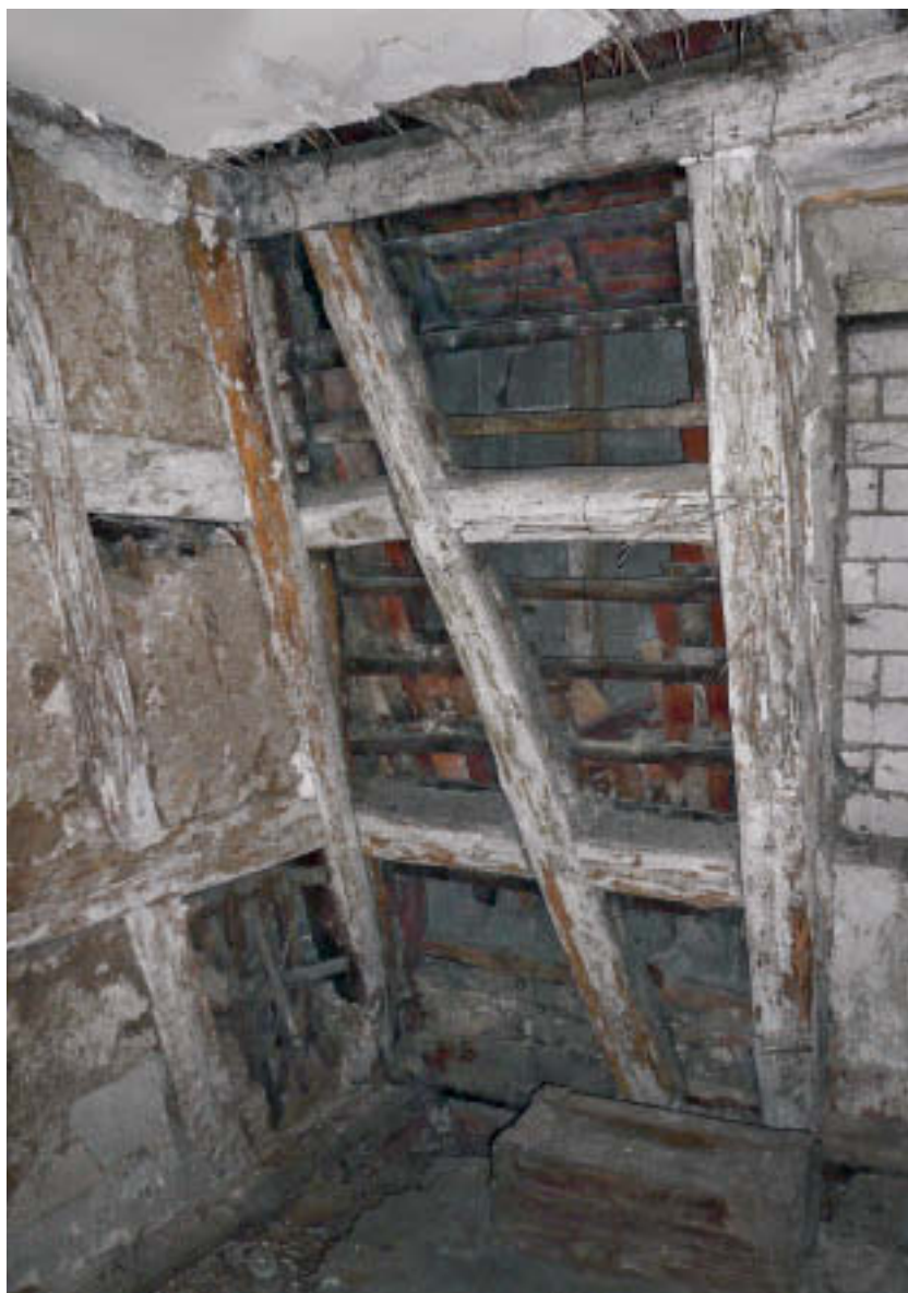
4 Waldstraße 9, Situation der hinter der Fassade erhaltenen Mansarde mit Resten der Ziegeldeckung.
