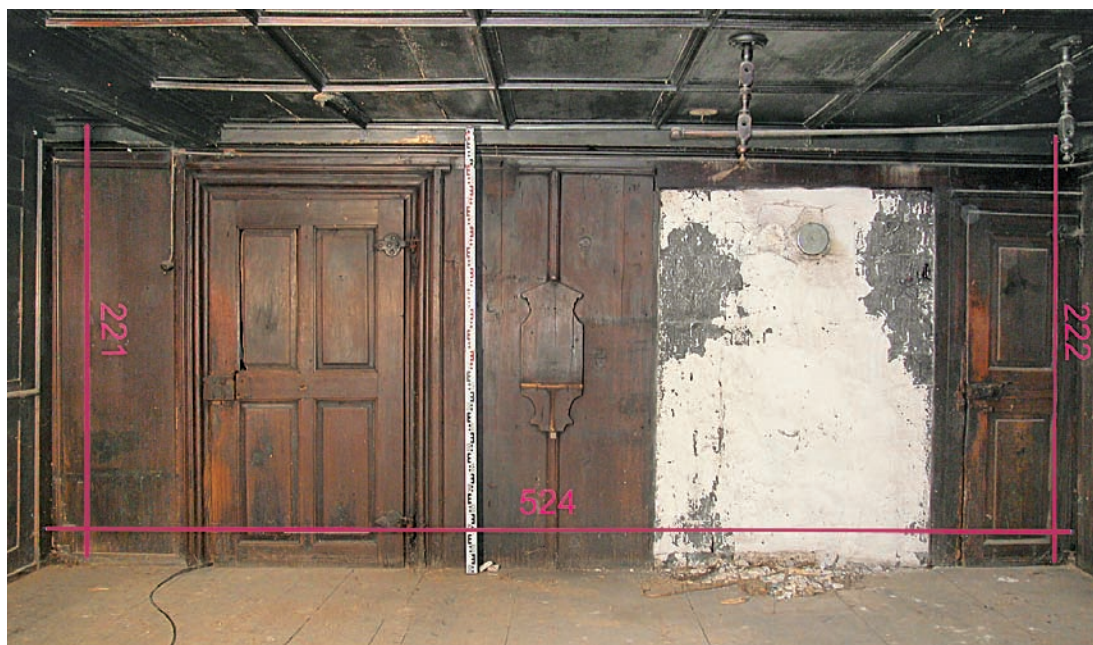
4 Mittlere Stube mit überputzten Tonkacheln.
