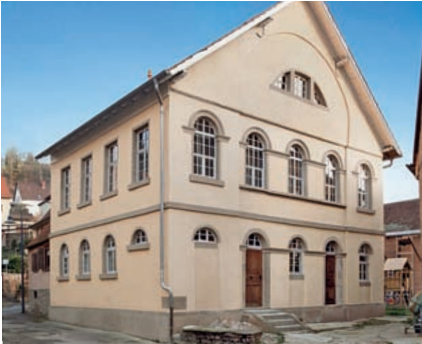
4 Die ehemalige Synagoge in Sinsheim-Rohrbach. Westfassade mit den beiden ehemaligen Eingängen.
