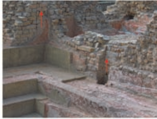
7 Badenweiler Heilthermen, Baderäume Bo/Bw: a) Grundriss; b) Schnitt durch Bo mit farblicher Hervorhebung von Heizraum und Wandschächten, Zeichnung H. Mylius, 1936; c) Südwestecke des Baderumes Bo mit vermauertem und geöffnetem Wandschacht (Pfeile), Foto G. Seitz, 2009.
