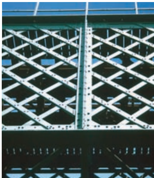
3 Untersicht-Detail des Gitterträgers.
