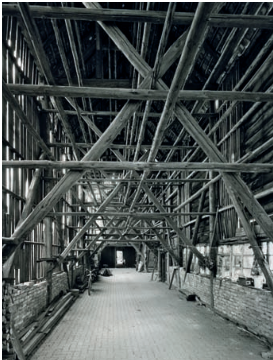
3 Hayna, Schuppen, um 1910, dichtes Innengerüst, teils mit Rundhölzern.
