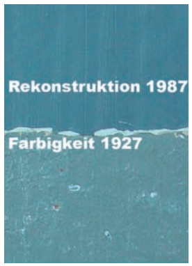
8 Mikroskopische Aufnahme einer Probeentnahme im Querschliff aus dem Treppenhaus von Haus Rathenastraße 1 mit Fassungsabfolge ab 1927.
