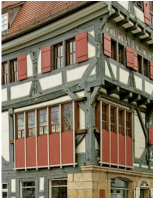
Hafenmarkt 10, Esslingen. Beispiel für nach Befund rekons- truierte Vertikalschiebeläden. (Foto: Iris Geiger-Messner, RPS)
