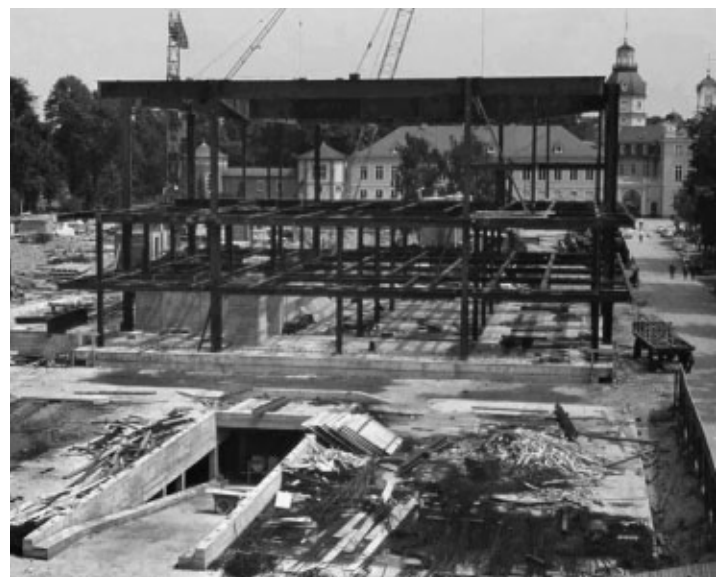
3 Stahlskelettbau des Sitzungsgebäudes, 1966.
