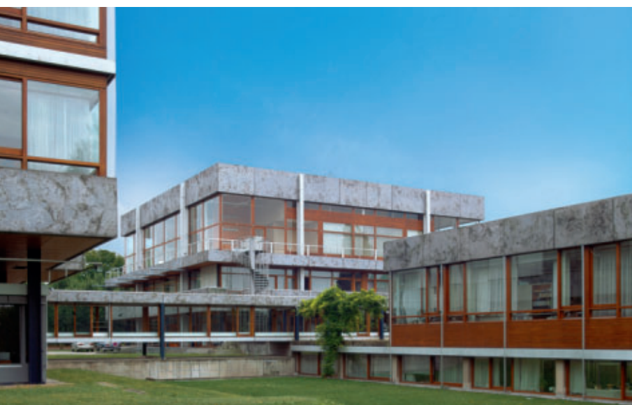
1 Bundesverfassungsgericht, Sitzungsgebäude (Mitte), Richtergebäude (links), Bibliothek (rechts).
