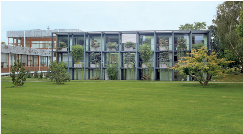
9 Richtergebäude, Blick in den Hof.
