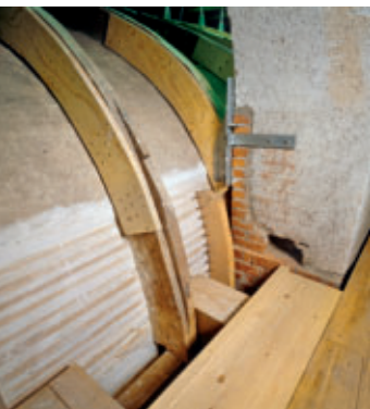
8 Dachraum, Blick auf die zurückgeschnittenen und mit Metallschuhen an den Wandpfeilern befestigten Schiffsgewöl- bespanten.
