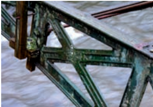
6 Detail der Konstruktion der Schiltachbrücke mit den gegossenen Auflagern für die frei eingelegten Gusstrittplatten.
