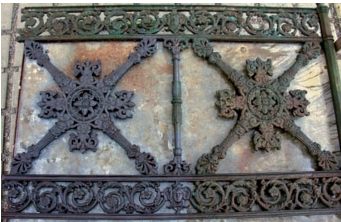
7 Geländersegment der Schiltachbrücke mit trockenestrahletem Bereich auf der linken Seite.
