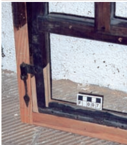
4–5 Die Reparaturstellen zeigen, dass der Holzaustausch auf das unbedingt Notwendige beschränkt wurde.
