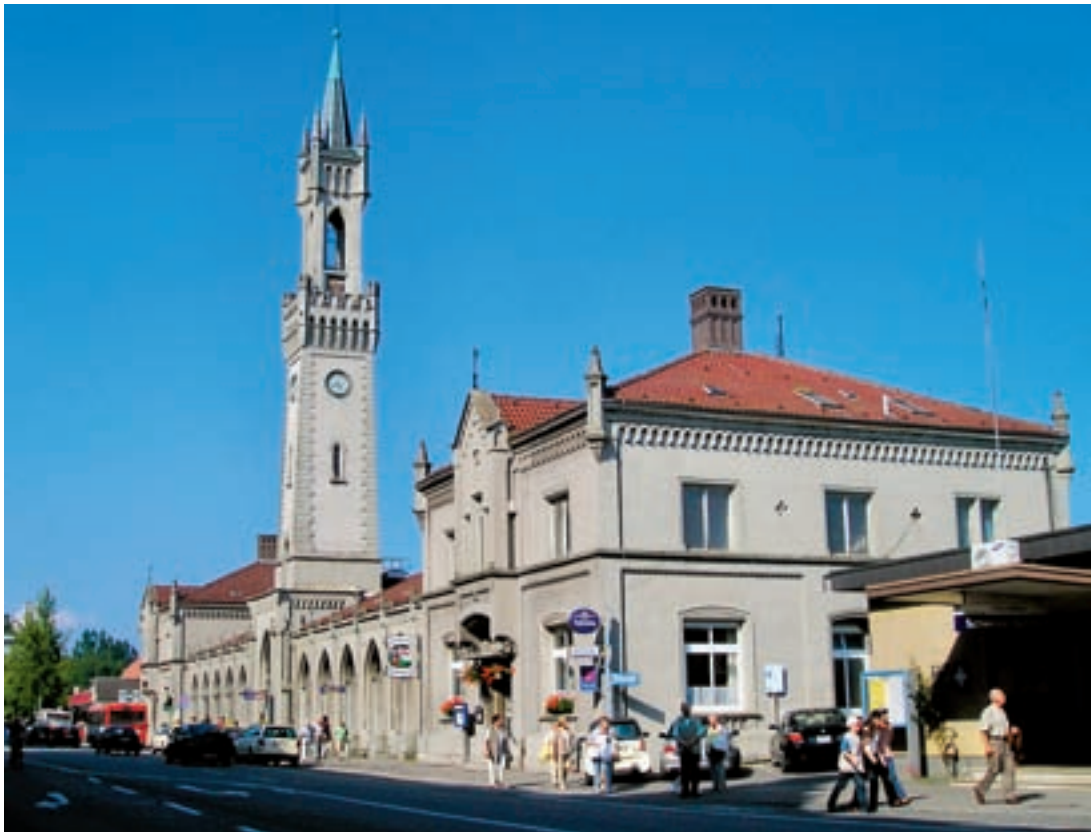
Empfangsgebäude des Bahnhofs Konstanz (links)
