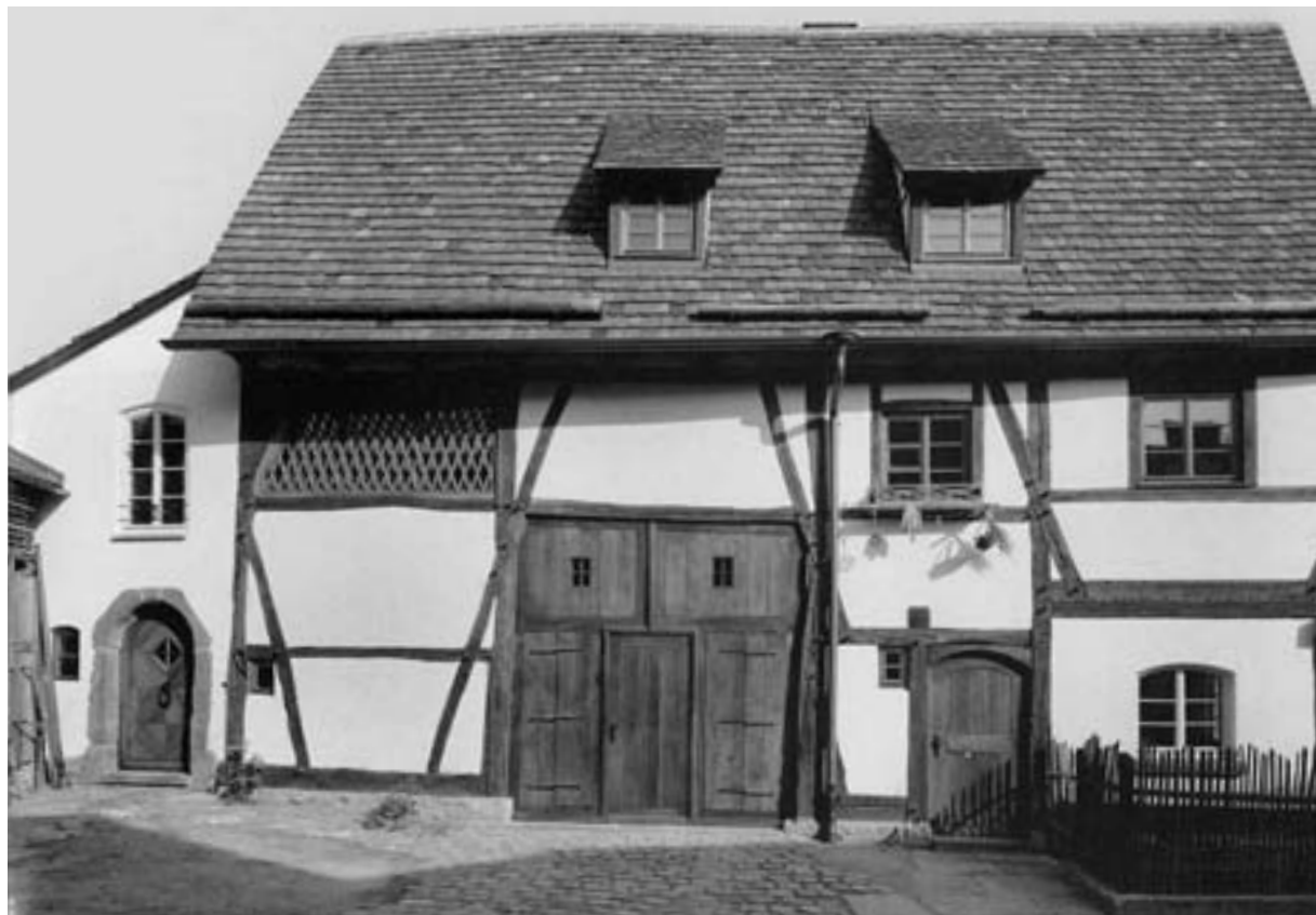
12 Rutesheim (Kreis Böblingen), Einhaus Schulstraße 8 von 1478, 1992 restauriert und ausgebaut, mit einer von der Schwäbisch Haller Hirtenscheuer angeregten neuen Belichtungsöffnung im Scheunenteil, Zustand 1992.
